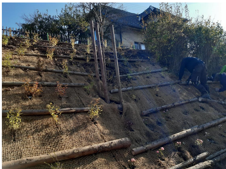
Výsadba dřevin, zálivka, mulčování borkou a překrytí druhou rohoží pro uchycení mulče.
