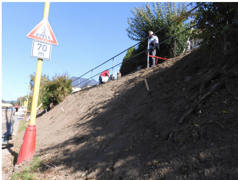
Příprava stanoviště pro výsadby – odpleveleno, terénní úpravy u zídky, instalace první rohože
