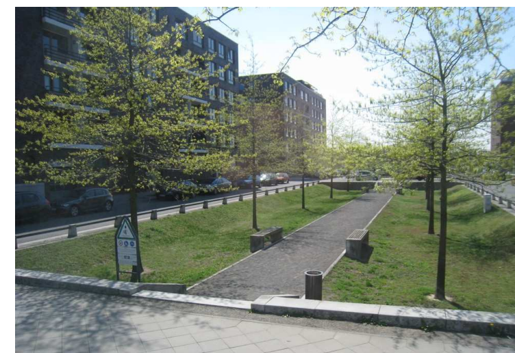
Povrchové vsakování dešťové vody z komunikací do zasakovacích průlehů (Berlín, Německo)
