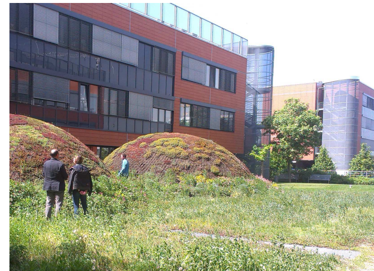
Střešní zahrada – zapojení sukulentních rostlin (Brno – Bohunice)
