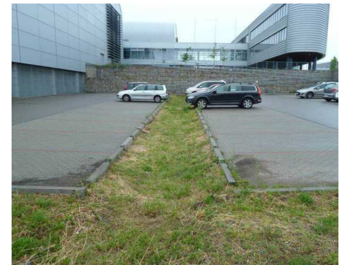
Průleh zasakující vodu sváděnou z plochy parkoviště
