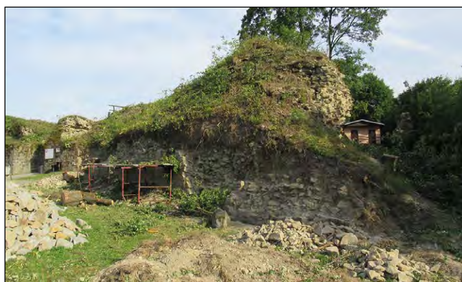
Bastion před opravou
