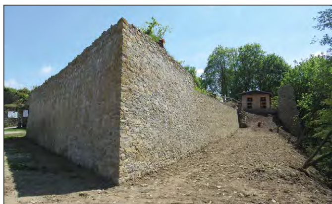
Bastion po opravě
