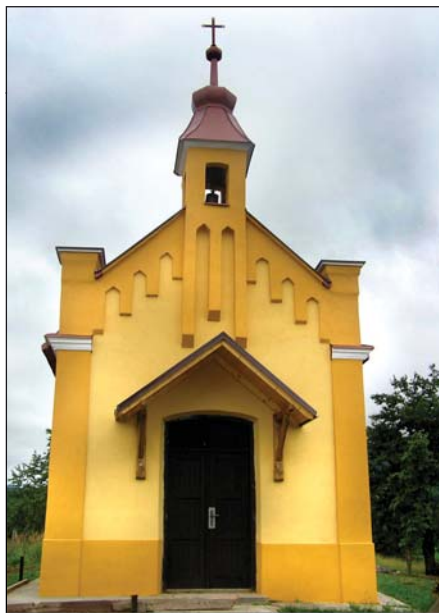
Oprava kapličky Sv. Anny
