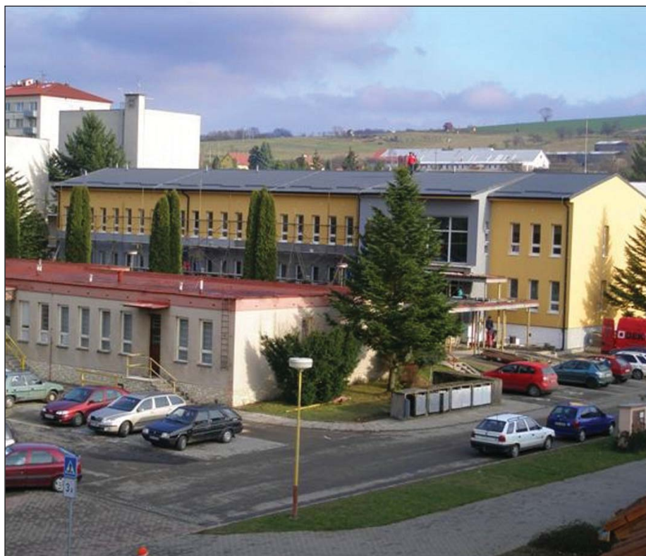
Zdravotní středisko s novou střechou, fasádou a výtahem
