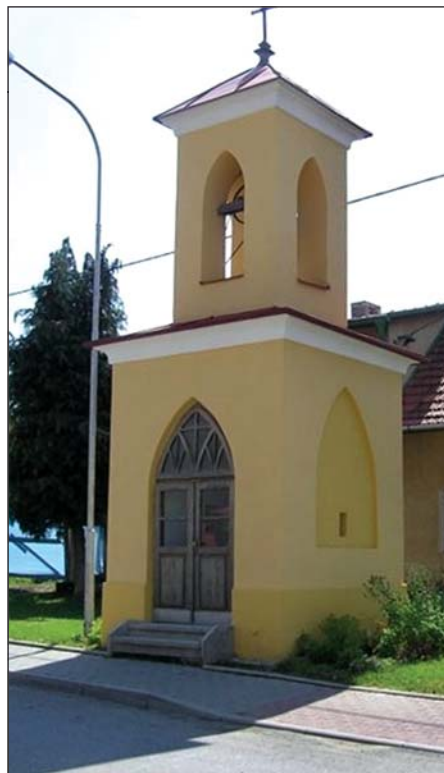
Opravená fasáda zvonice v Bylnici
