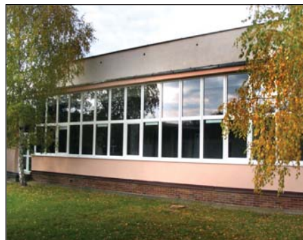
Nová prosklená stěna krytého bazénu
