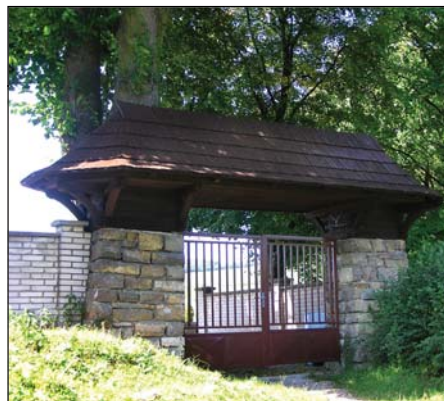
Opravená horní brána na hřbitově
