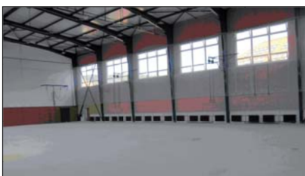
Úpravy tělocvičny ZŠ před dokončením
